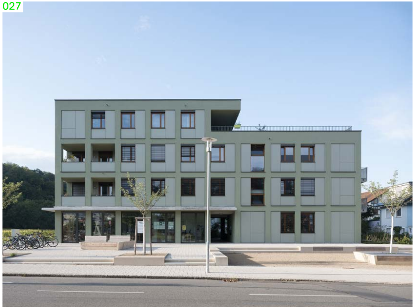
D Tübingen, Passerelle (→ 32): Wohnraum und Unterstützung beim >heimisch werden<
