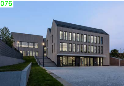
K Walzbachtal, Neubau Rathaus Wössingen mit Rathausplatz (→ 36): Passivhausstandard
