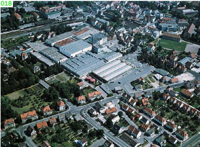
C Kirchheim u. T., Steingauquartier (→ 17): Ausgangssituation – Maschinenfabrik (1975)
