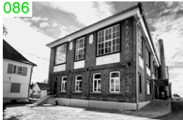
Gomaringen, Umbau ehem. Kindlersche Fabrik (→ 11): Das neue Dienstleistungszentrum der Gemeinde
