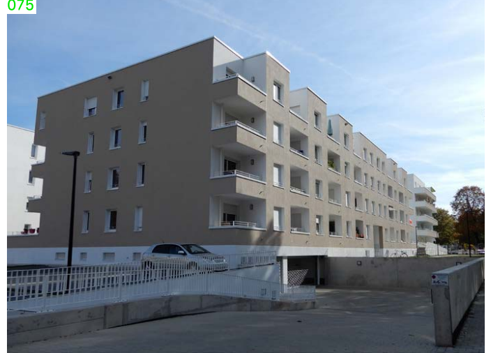
K Lahr, Sanierung Wohngebiet Kanadaring (→ 20): 268 Wohnungen wurden bereits umfassend modernisiert
